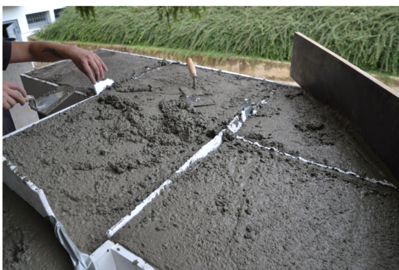
Obrázek 36: Betonáž zkušební bloku (Jaroslav Šnědar).
