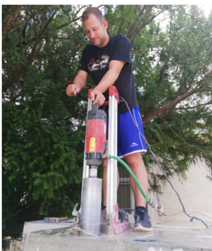
Obrázek 44: Vrtání jádrovou vrtačkou Hilty DD 130.
