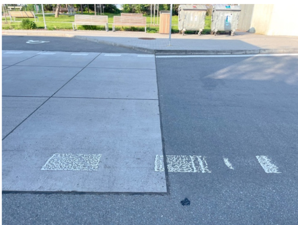
Obrázek 21: Detail napojení WT a asfaltové vozovky.
