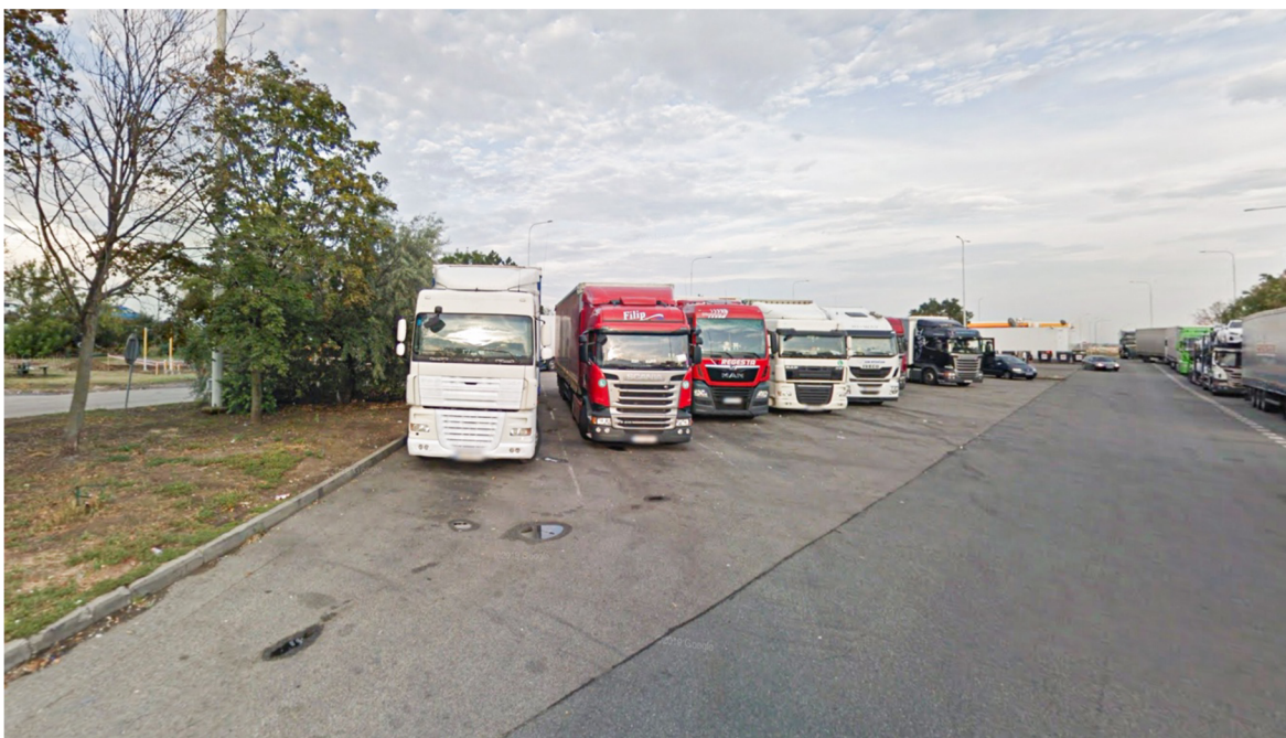
Obrázek 18: Dálniční odpočívka Ladná před rekonstrukcí. Je zde vidět dříve provedená oprava asfaltového krytu na příjezdových komunikacích (Google Street View 2018).
