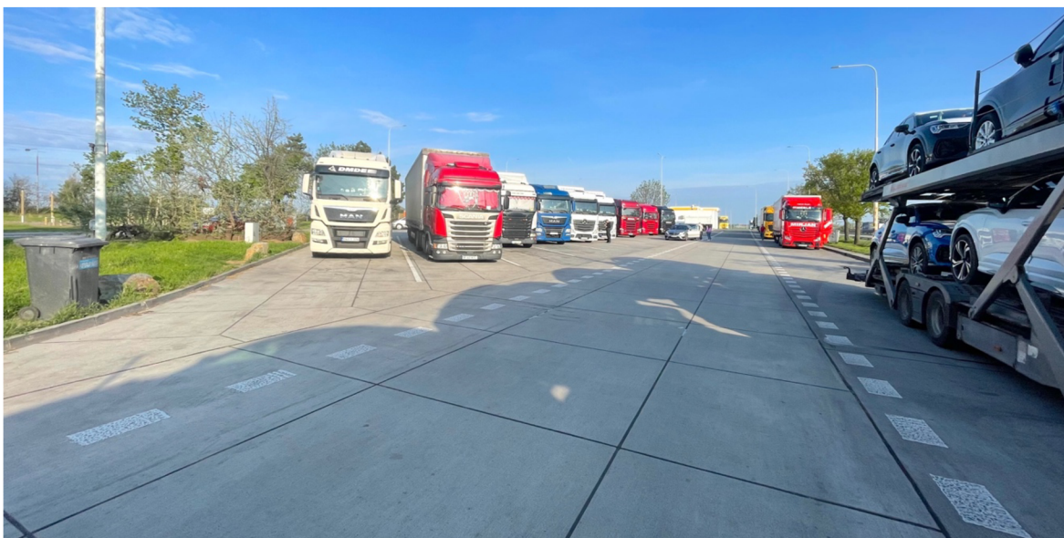
Obrázek 11: Zrekonstruovaná dálniční odpočívka Ladná metodou TWT.
