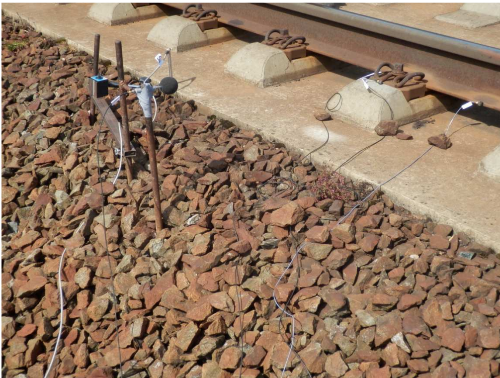
Obr. A.8 Pohľad na umiestnenie snímačov - PJD
