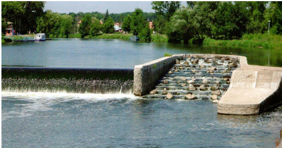
Obrázek 2. Migrační rampa na řece Dyje v Břeclavi. (zdroj: Adámek a kol., 2015)
