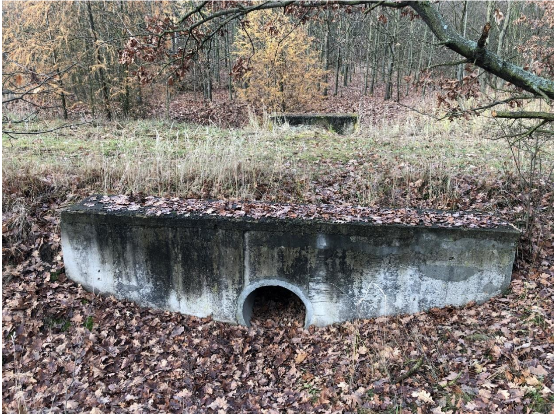
Obr. 7: Propustek vedoucí pod cestou (foceno autorkou práce)
