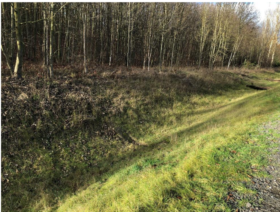
Obr. 3: Odvodňovací příkop u východní paty výsypky (foceno autorkou práce)
