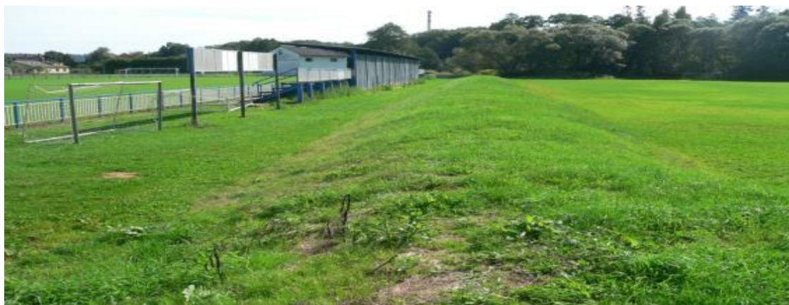
Obrázek 22: Ochranná zemní hráz na fotbalovém stadionu
