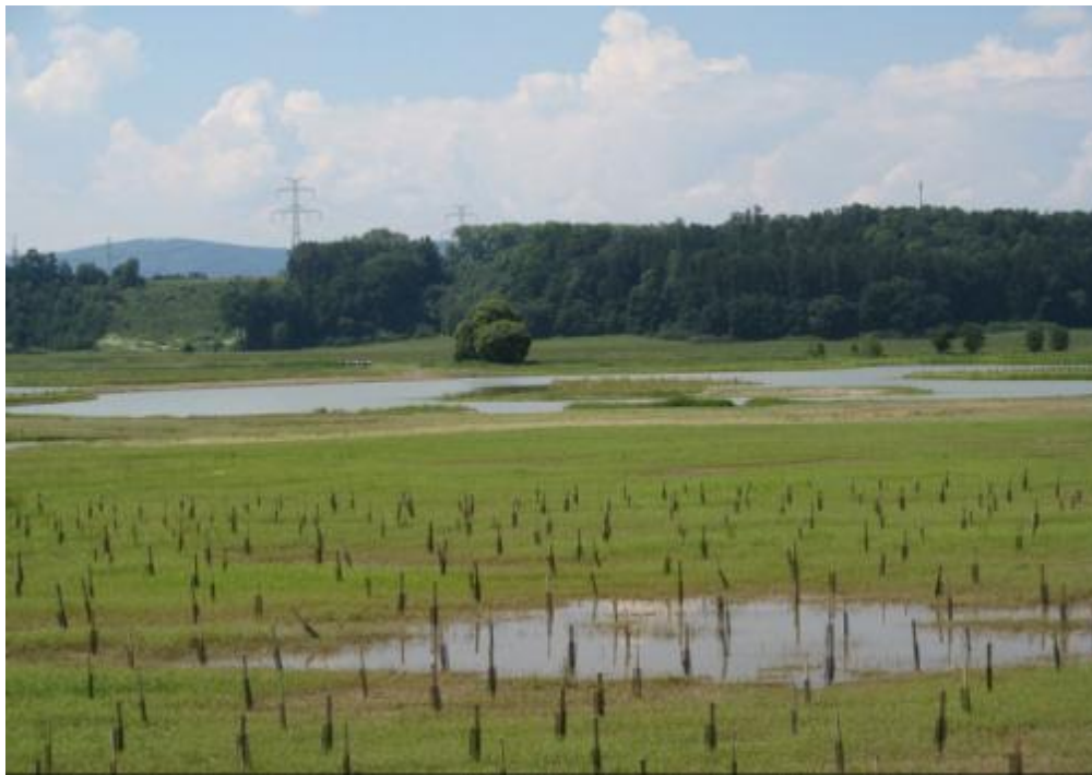
Obrázek 3: Suchá retenční nádrž Žichlínek po dokončení
