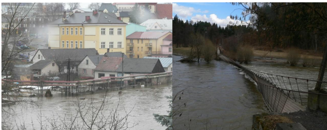
Obrázek 12: Zatopení domů v Jelenově ulici ve Světlé nad Sázavou (vlevo)
