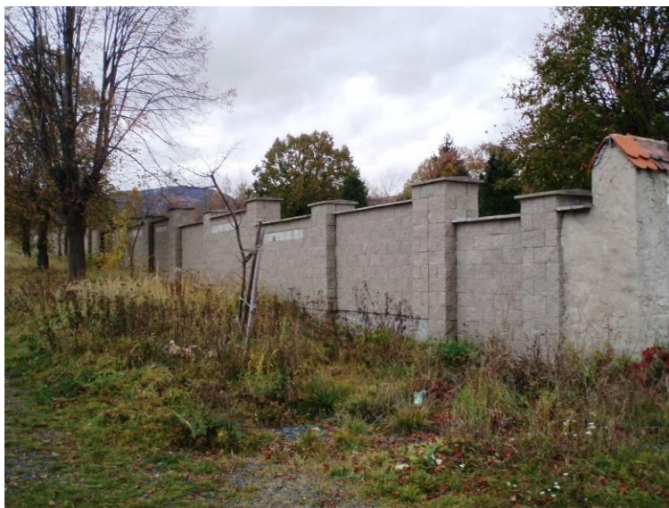
Obr. č. 16: Košťanský hřbitov – opravená zeď po sesuvu svahu
