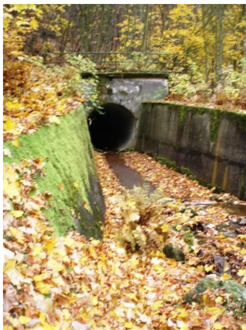
Obr. č. 7: Výtok ze štoly Jezeří
