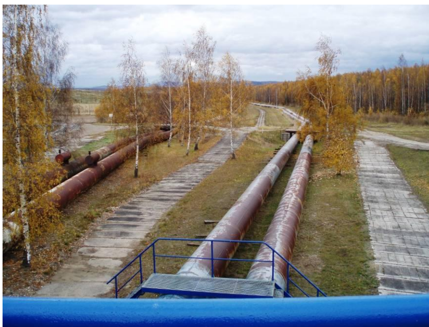
Obr. č. 11: Řeka Bílina svedená do potrubí (Ervěnický koridor)
