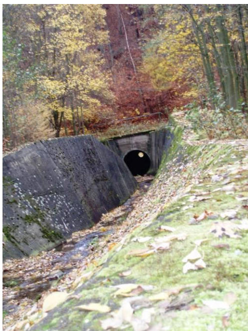
Obr. č. 6: Vtok do štoly Albrechtice
