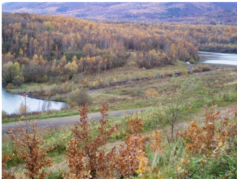
Obr. č. 15: Nádrže Barbora – Otakar
