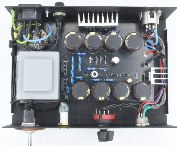
Obr. 4.2: Pohled do vnitřku napájecího zdroje
