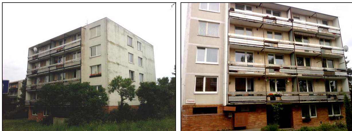
Obr. č. 29, 30 – Panelové domy – 5 podlažní dům typ T06B (ulice Třískalova, původní stav bez revitalizace)
