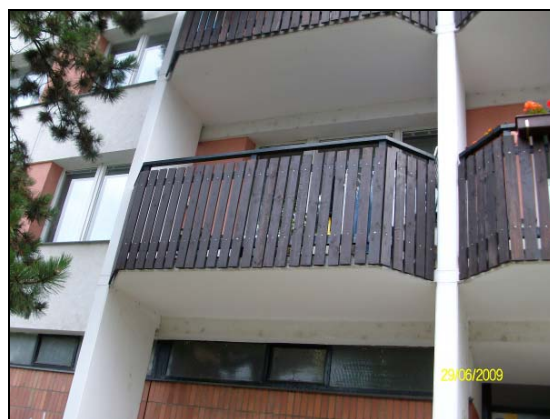
Obr. č. 44, 45 – Lodžie se zalomeným čelem s plnou boční stěnou, foto z ulice Vaculíkova (červenec 2009), (výkres převzat z [14])
