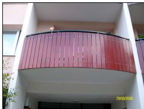
Obr.č. 46, 47 – Lodžie se zaobleným čelem s plnou boční stěnou, foto z ulice Slavičkova (červenec 2009), (výkres převzat z [14])
