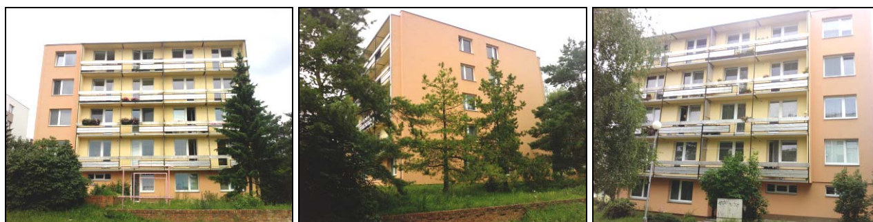
Obr. č. 31, 32 – Panelové domy – 5 podlažní dům typ T06B (ulice Třískalova, po revitalizaci)
