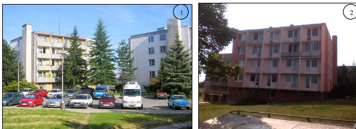
Obr. č. 33, 34 – Panelové domy – 4 podlažní dům typ T06B (ulice Barvy: 1. foto – původní stav bez revitalizace, 2. foto – po revitalizaci)
