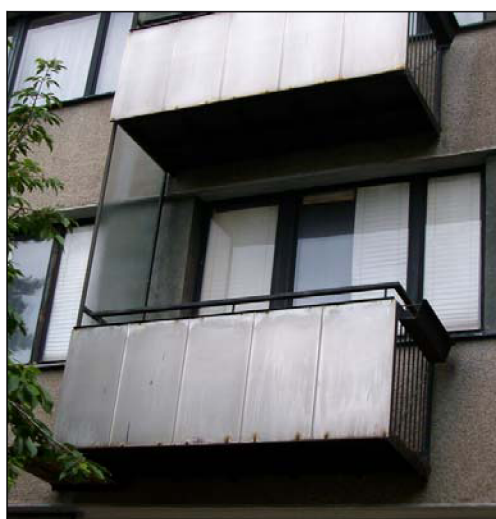
Obr. č. 43 – Původní závěsné balkóny z roku 1962-1970, foto z ulice Brožikova (červenec 2009)
