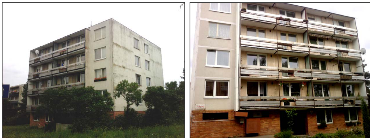
Obr. č. 29, 30 – Panelové domy – 5 podlažní dům typ T06B (ulice Třískalova, původní stav bez revitalizace)
