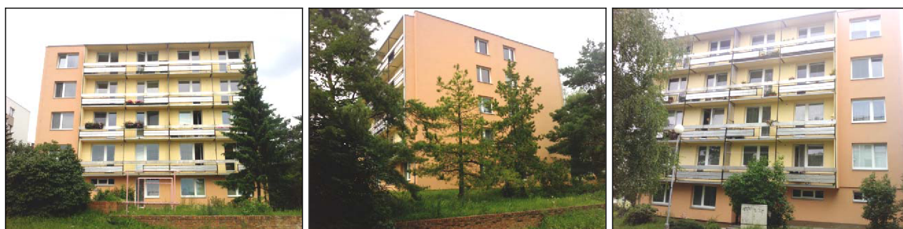
Obr. č. 31, 32 – Panelové domy – 5 podlažní dům typ T06B (ulice Třískalova, po revitalizaci)
