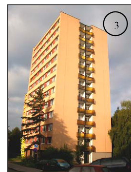
Obr. č. 22, 23, 24 – 13 podlažní věžový dům typ B60 s parapetním pláštěm (ulice Haškova) (1 foto - převzato z [11] - 1965 – původní stav, 2 a 3 foto – 2009 - po revitalizaci)
