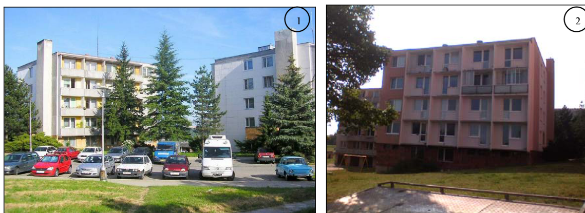
Obr. č. 33, 34 – Panelové domy – 4 podlažní dům typ T06B (ulice Barvy: 1. foto – původní stav bez revitalizace, 2. foto – po revitalizaci)
