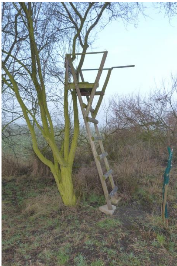
Obrázek č. 25 - Žebříkový posed, č. 21 podložený betony s podpěrou stromu.
