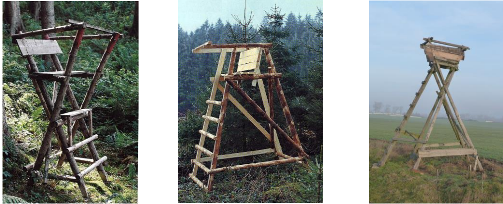
Obrázek č. 12 - Nůžkový posed [2] a žebříkový posed s integrovaným podstavcem [2] a nůžkový posed s žebříkem
