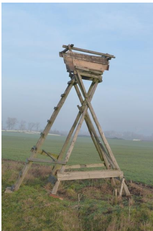
Obrázek č. 22 - Nůžkový posed s žebříkem, č. 6 podložený betonovými kameny, bez přirozeného zákrytu v zimě. Okolní pole v létě oseta kukuřicí a řepkou.
