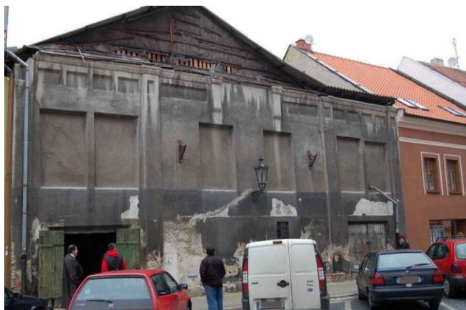
Obr. 19 Rekonstrukce žatecké sladovny. Zdroj: Kinšt, 2009.
