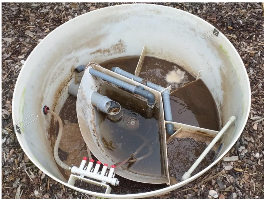
Obr. 5: Pohled na odkrytou DČOV (typ AT6 od firmy Aquatec) během čistícího procesu na zahradě rodinného domu (Vlastní foto, říjen 2020)
