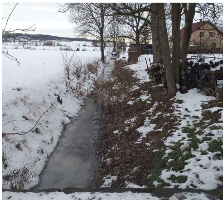
Obr. 13: Újezdecký odpad na jižním okraji obce (Vlastní foto, únor 2021)
