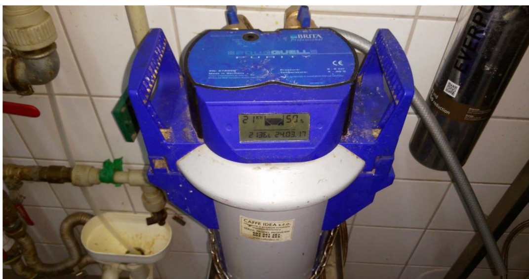
Obrázok 6.2 Detail filtračného systému BRITA
