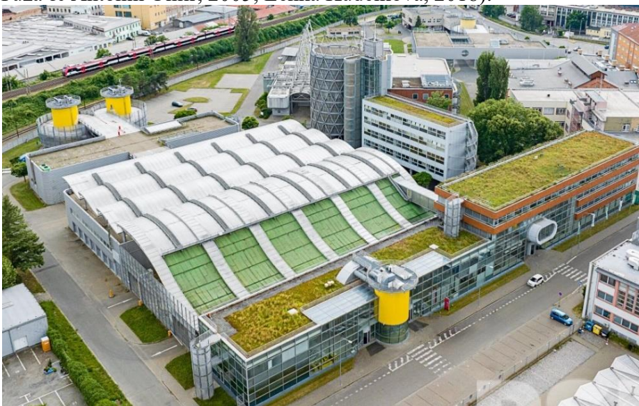
Obrázek 12 Pohled na budovu F1 v Plynárenské ulici, v popředí část objekt E (PSN s.r.o., 2023).
