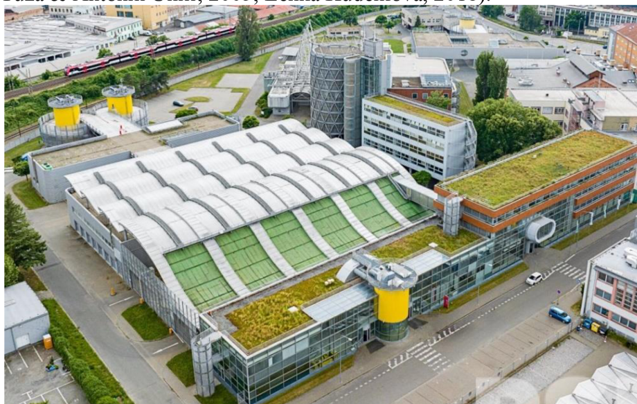
Obrázek 12 Pohled na budovu F1 v Plynárenské ulici, v popředí část objekt E (PSN s.r.o., 2023).
