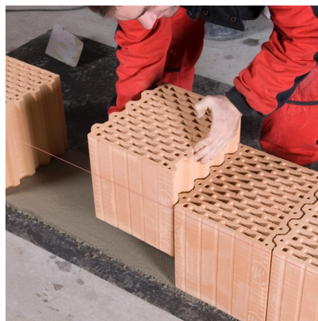
Obrázek 30: Položení první vrstvy zdiva [4]
