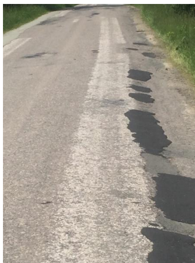
Foto 17: Povrch vozovky (Zdroj: Vlastní)
