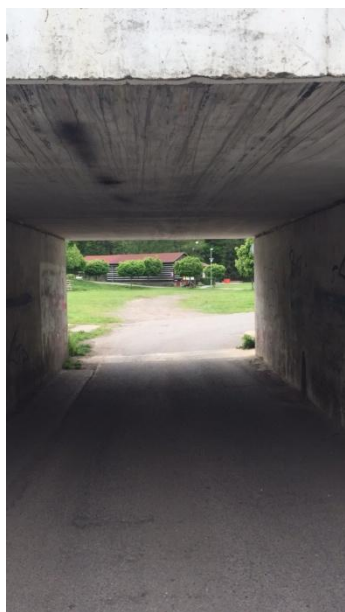
Foto 3: Železniční podjezd (Zdroj: Vlastní)
