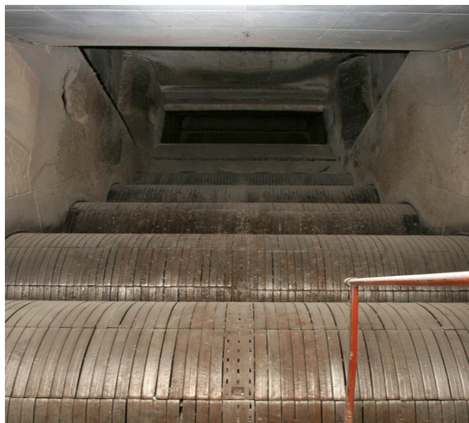
Obr.1-21 Pohled do spalovací komory
