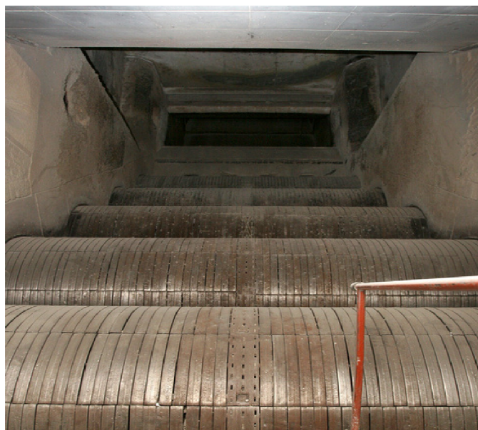
Obr.1-21 Pohled do spalovací komory
