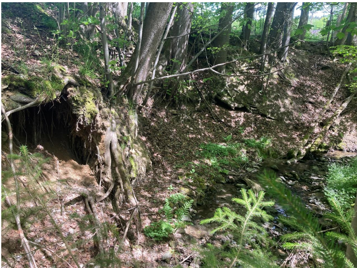
Obr. 22: Sesouvání č. 49 v lokalitě Pod Kání v Hutisku-Solanci na pravém břehu potoka Kaňůvka, vlastní foto 2024
